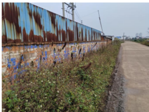
项目场地西面道路
