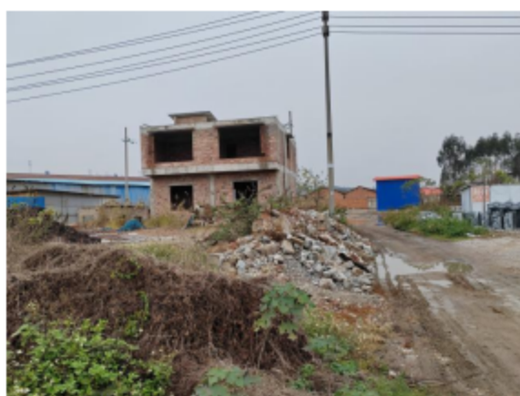
项目场地南面在建房及道路
