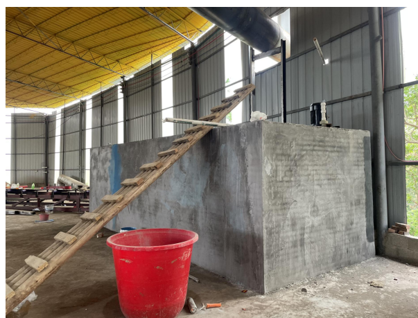
喷淋塔循环水池（3个 8\text{m}^3 ）
