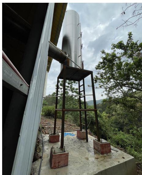
DA001 排气筒、喷淋塔（正在安装中）
