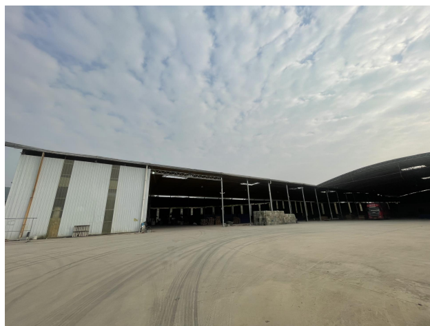
生产厂房（未建设前）
