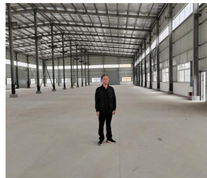
项目编制主持人现场踏勘照片
