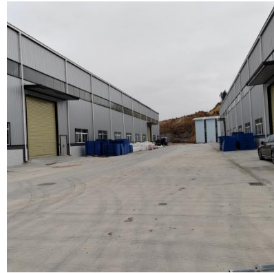
项目厂房北面
