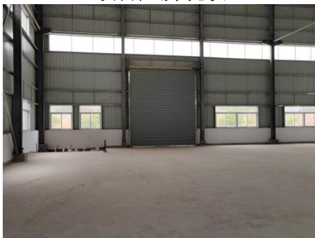
项目厂房现状
