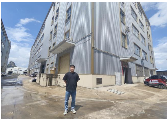
工程师现场踏勘
