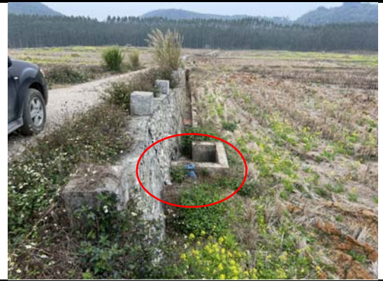
南部灌区放水闸阀
