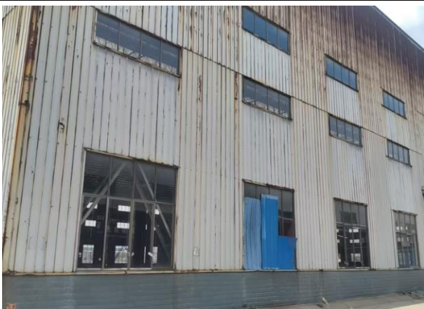
项目厂房现状
