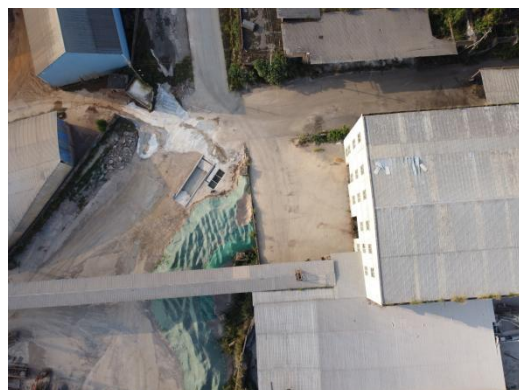
项目北面厂区道路及铁件原料厂房
