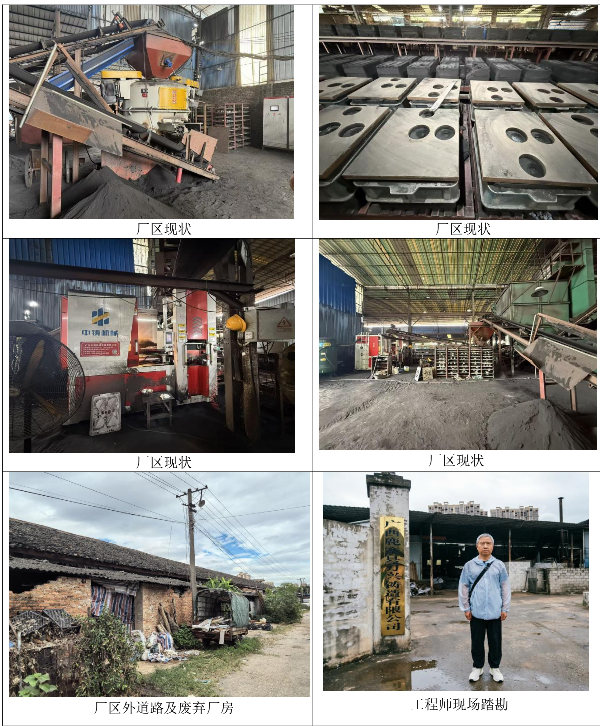
附图 3 项目场地及周边概况照片
