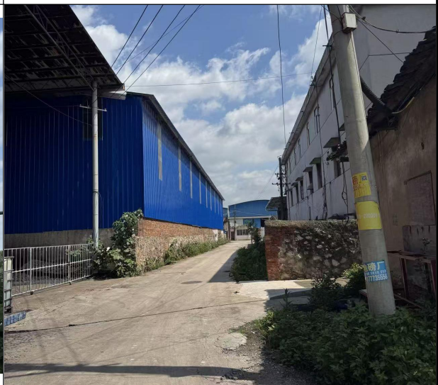
项目厂界北面
